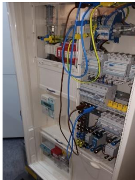
Verteiler, wie ihn unsere Lehrlinge auch in der Prüfung verdrahten müssen.
